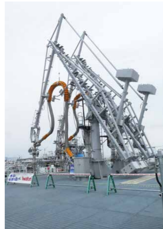
ローディングアームは2本。1つの配管で液化水素を、もう1つの配管で水素ガスを移送し、液化水素を抜いた分、タンクに水素ガスを充てんする
