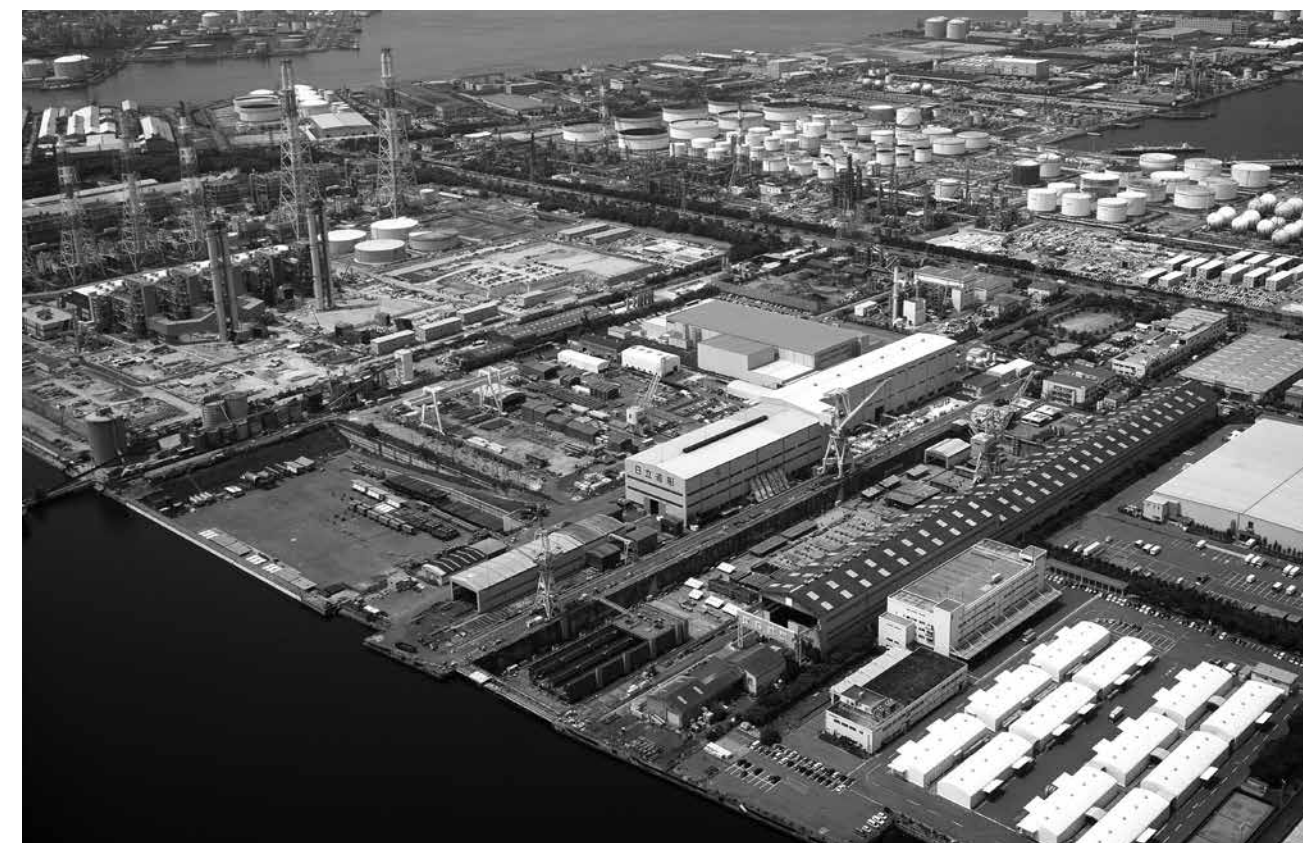
海洋構造物専用ドックを有する堺工場
