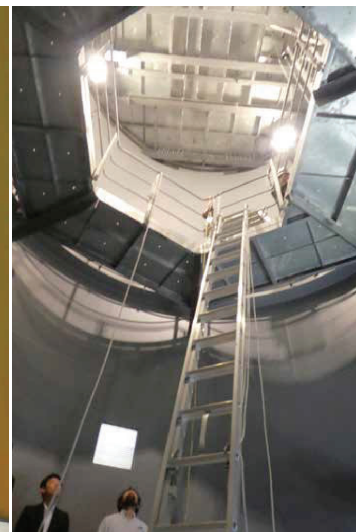
トランジションピースの内部
