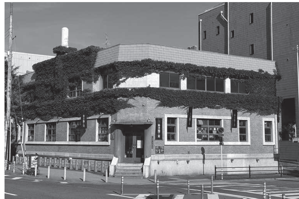
元々はみなと通り(写真左側)から見て凸型の建物だったが、両肩部分を後に増築した。建物上部の明るいところが増築部にあたる
