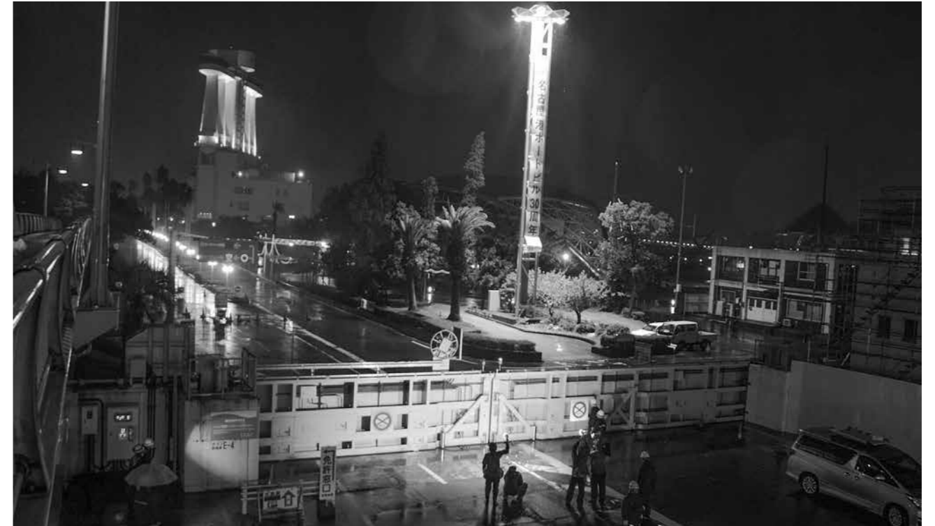
ガーデンふ頭に設置している電動式の防潮扉
