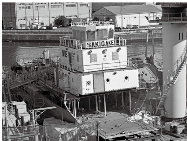
改造工事が進むタグボートの「魁」
