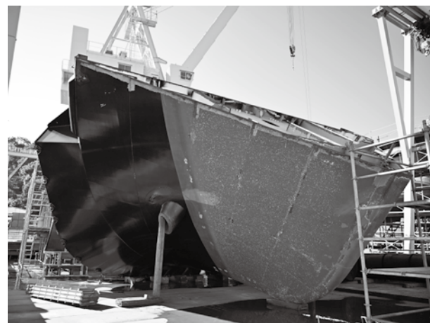
機器の入れ替えのために切断された船体
